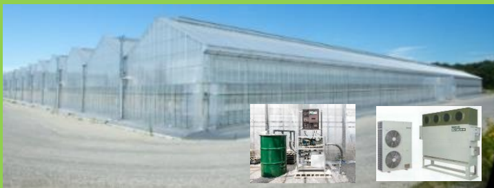
CO 2 貯留・供給装置 ヒートポンプ
