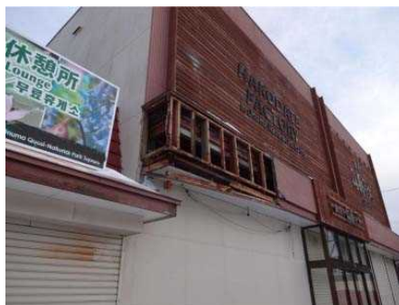
外壁落下後の建物写真②
