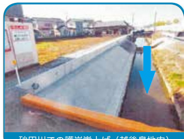
砂田川での護岸高上げ (越後島地内)
