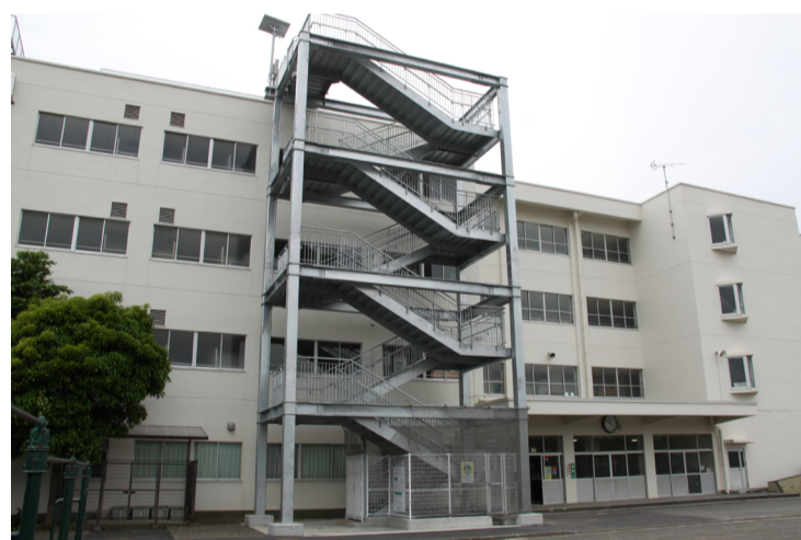
▲平成 26 年度焼津東小学校に外付け階段を整備しました
