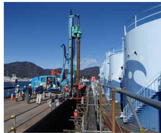
▲鋼管杭基礎工施工状況 (提供：静岡県焼津漁港管理事務所)
