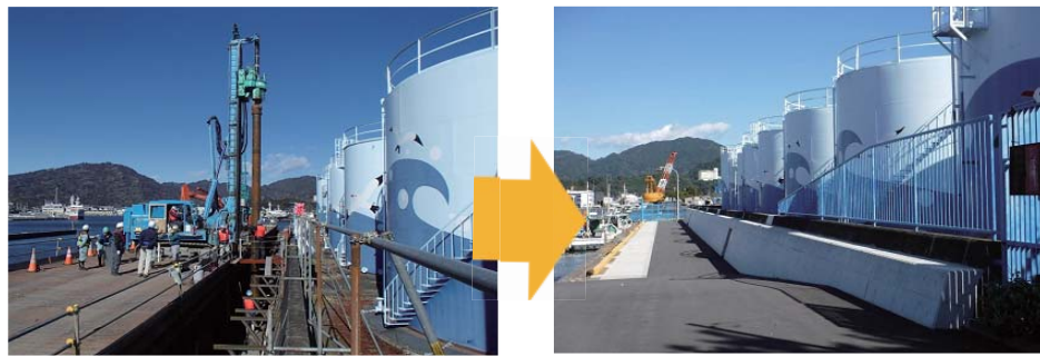
▲鋼管杭基礎施工状況
