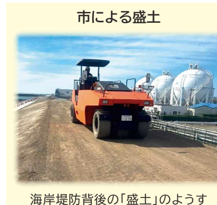
県河川区域の「裏法被覆工」のようす
