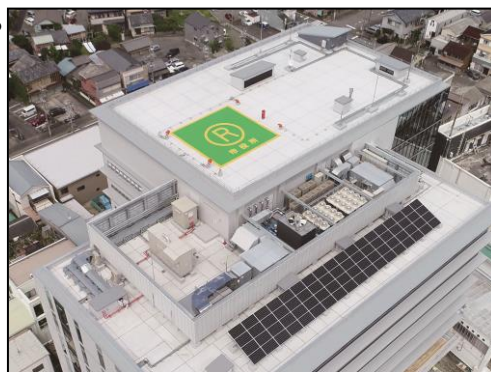
本庁舎の太陽光発電設備
