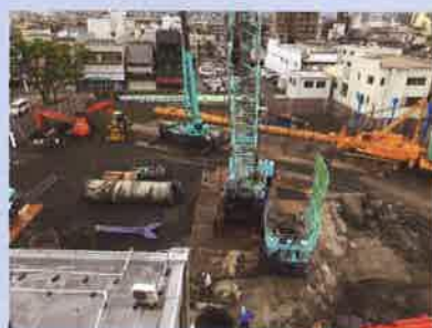
始まった新庁舎建設工事：現本庁舎西側
