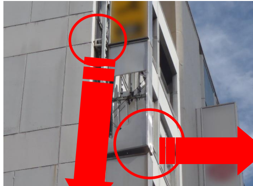
←取付金具のサビや腐食。ボルトやビス等が欠落していたら緊急の対応が必要。放置すると看板が落下する恐れも。
