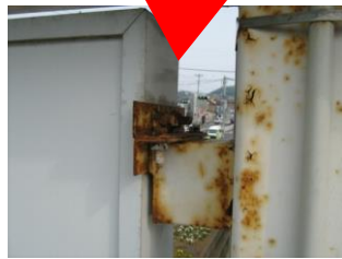
←取付金具のサビや腐食。ボルトやビス等が欠落していたら緊急の対応が必要。放置すると看板が落下する恐れも。
