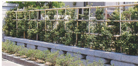
ブロック積み擁壁
