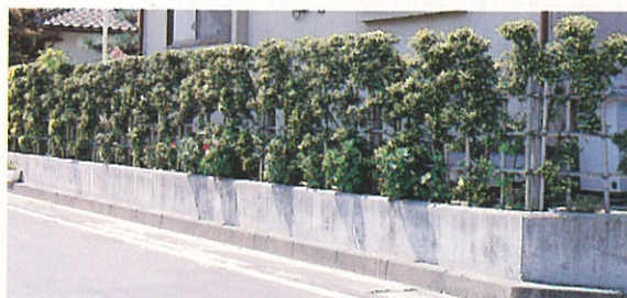
コンクリート擁壁
