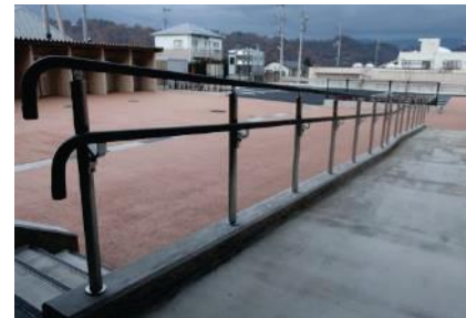
写真Ⅱ.68 子ども用手すりが設置された 2 段手すりのスロープ
