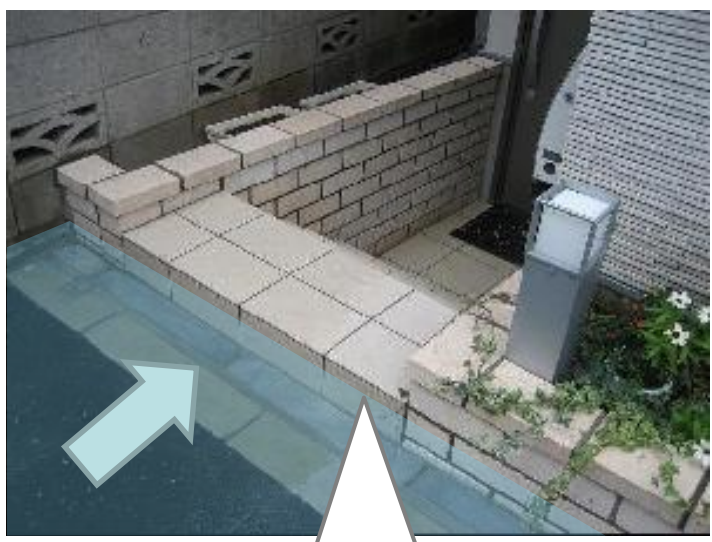
防水性の塀により浸水を防ぐ。
