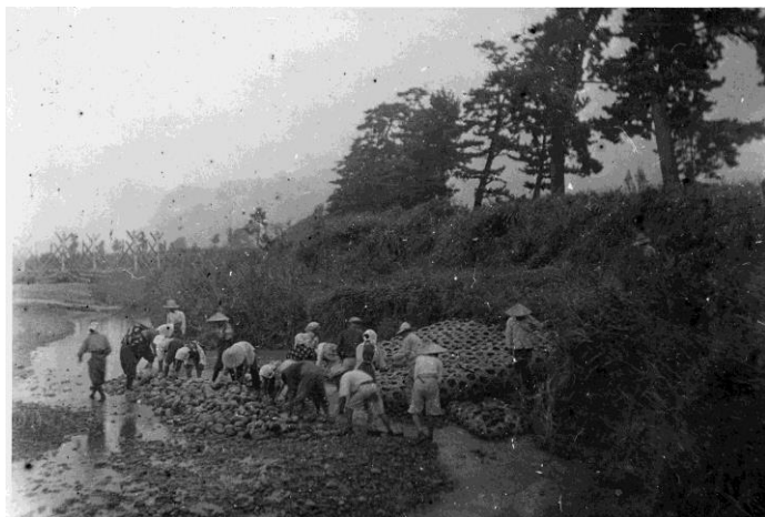
飯渕付近 突出し堤破損
