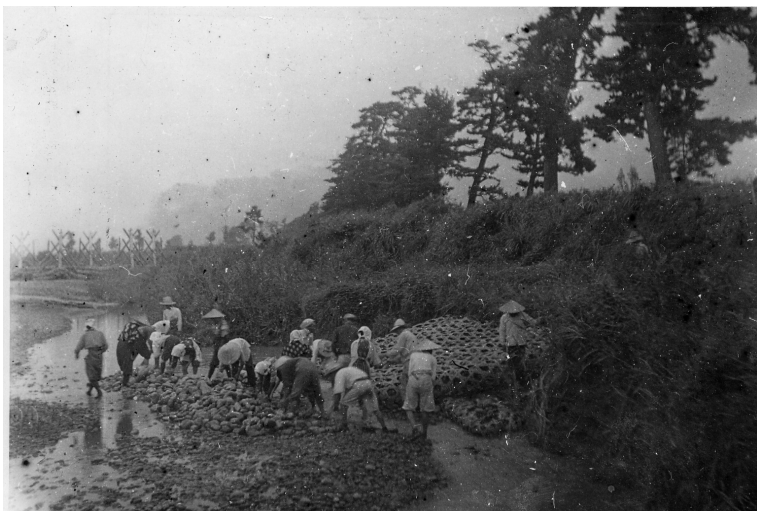
飯渕付近 突出し堤破損
