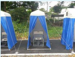
使用する際はマンホール蓋を開け、簡易トイレをセットします。プライバシーは簡易テントで守られます。平成30年度は、2基(38穴)のマンホールトイレを整備します。
