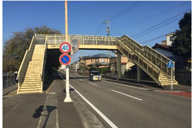
焼津 2 丁目歩道橋
