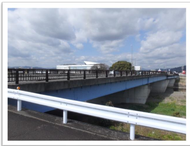
【鋼橋】あかつき大橋（市道鯛ヶ島八楠線）
