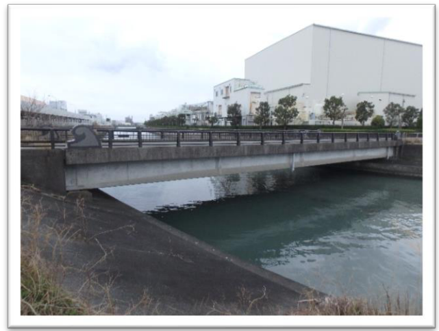
【PC 橋】仲良し橋（市道 1706 号線）
