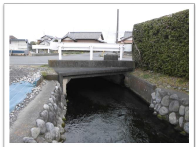
【BOX 橋】清水橋（市道 1700 号線）
