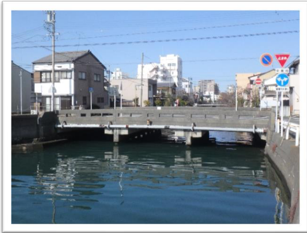
【RC 橋】須原橋（市道昭和線）
