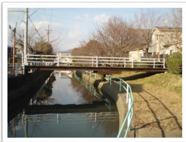
【木橋】無名橋 00385（市道青峰公園線）
