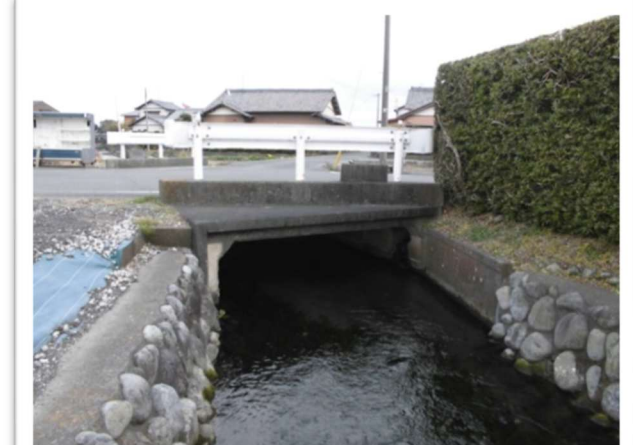
【BOX 橋】清水橋（市道 1700 号線）
