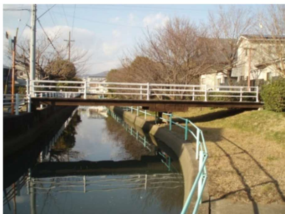
【木橋】無名橋 00385（市道青峰公園線）
