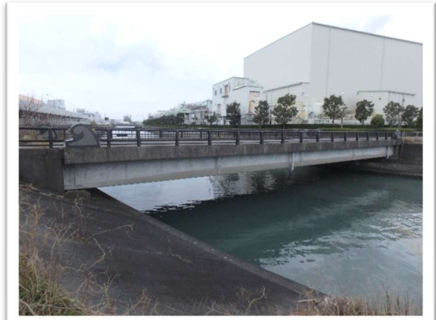
【PC 橋】仲良し橋（市道 1706 号線）
