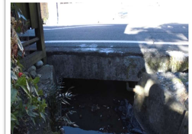
【石橋】無名橋 10083（市道 0208 号線）
