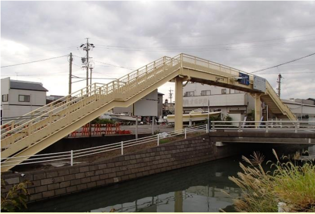
浜当目 1 丁目歩道橋
