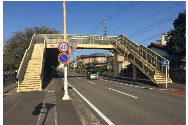
焼津 2 丁目歩道橋
