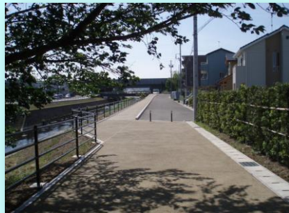
リバーサイド遊歩道整備
