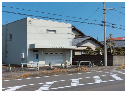
大井川防災倉庫 (宗高地内)
