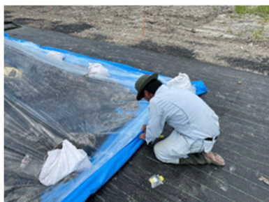
② 盛土の被覆と密閉
