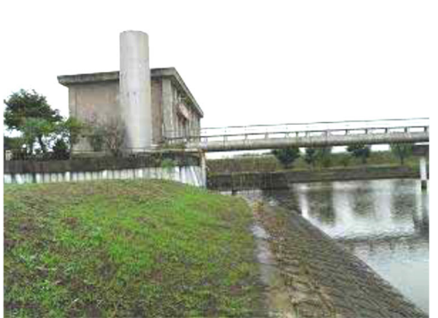
排水機場の法面での生育状況
