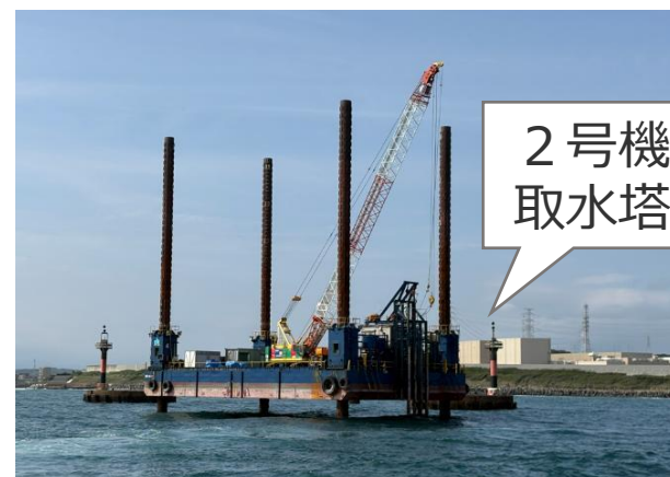
取水塔付近の作業船の様子
