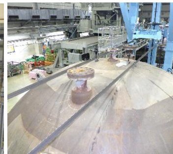
切断作業着手
