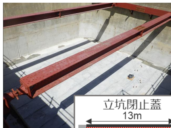
立坑閉止蓋 (現在の状況 (2026.6時点) )
