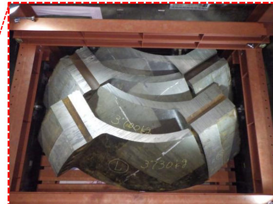
解体物は近傍のピット内へ収納
