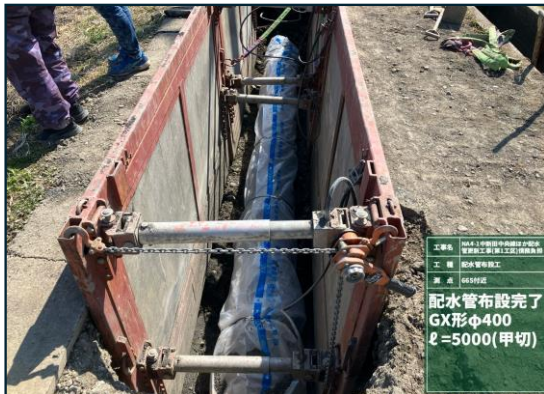
【配水管布設状況】
