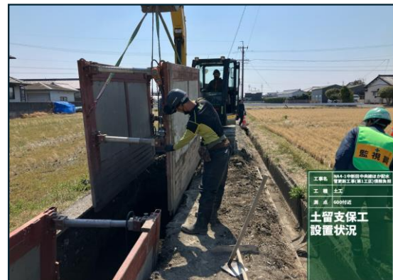
【スイング式パネル土留設置状況】
