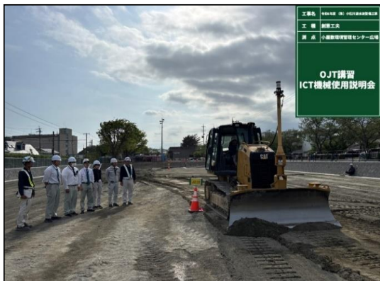
【ICT機械使用説明会実施状況】
