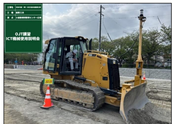
【ICT施工実施状況】
