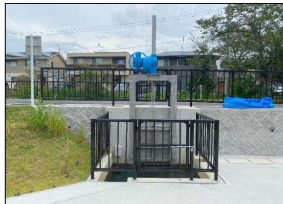
【取水口設置状況】
