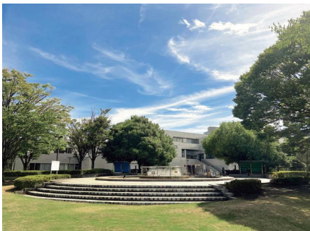
現在の清見田公園噴水施設
