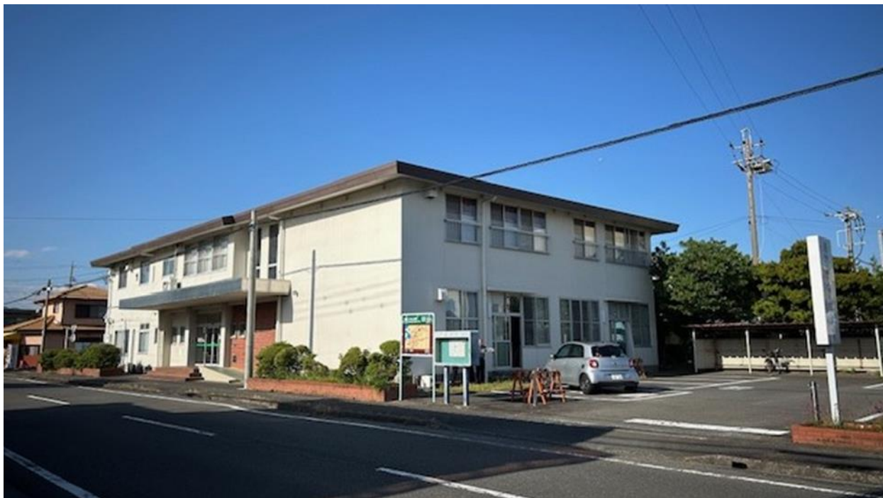
既設建物 外観
