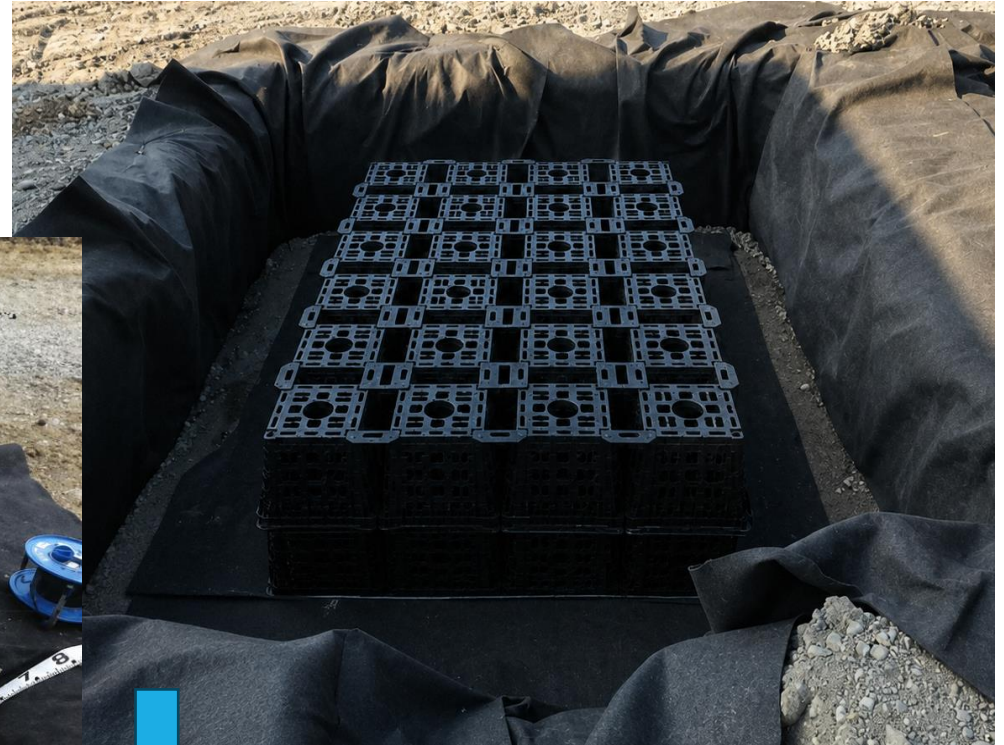
雨水浸透施設組立状況
