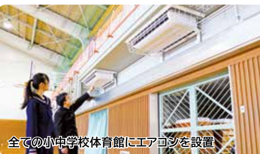
全ての小中学校体育館にエアコンを設置
