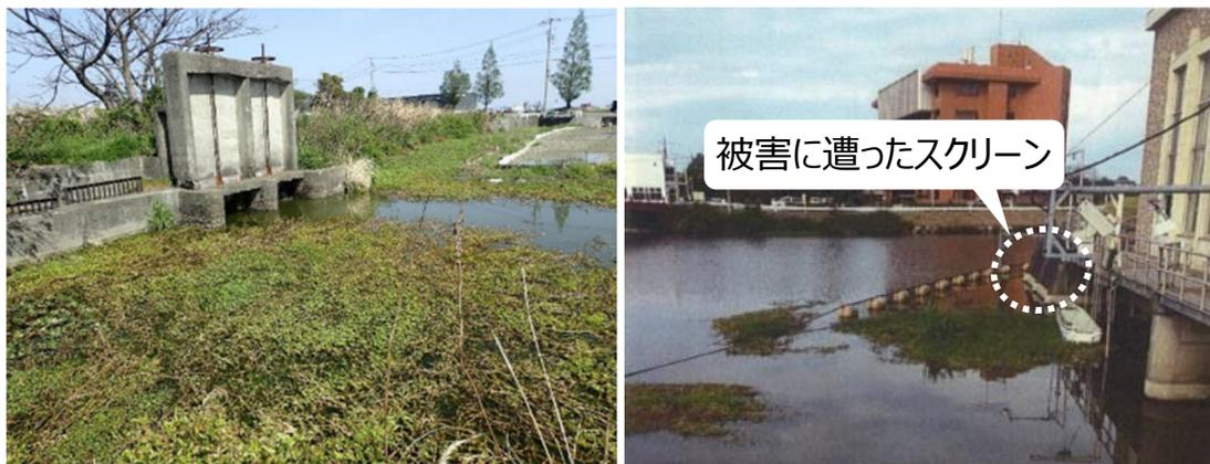
水路を閉塞し、取水・排水の障害となる 排水機場のスクリーン周辺に溜まり目詰まり
