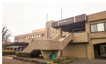
焼津市役所大井川庁舎
