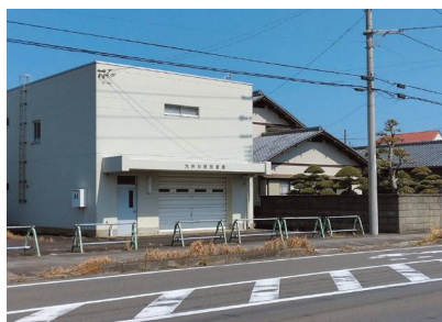
大井川防災倉庫 (宗高地内)
