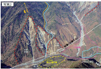
ツバクロ発生土置き場の西側を撮影。対岸斜面、上千枚沢の土石流堆
