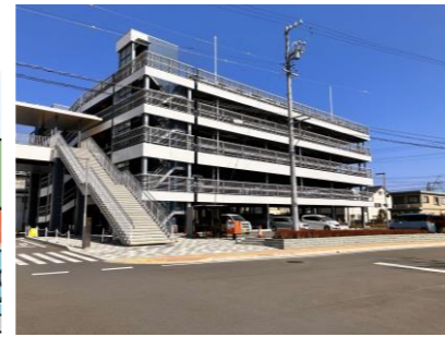
△ 自走式立体駐車場
