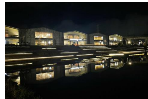
△ 夜間照明イメージ(柏の葉アクアテラス)
