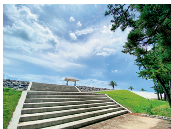
ディスカバリーパーク海側にある海岸堤防のうち真ん中の階段
