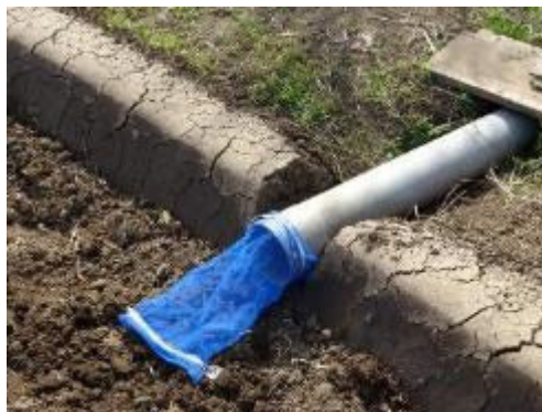
取水口への網の設置
