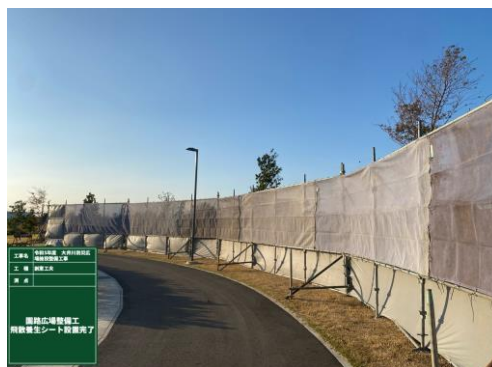
【防塵対策(飛散養生シート設置)】
