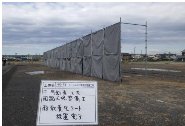
【防塵対策(飛散養生シート設置)】
