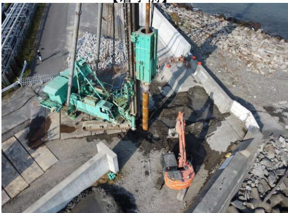
【施工中(鋼管杭)】
