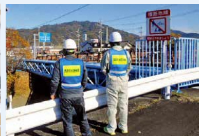
▲水道施設（水管橋）点検訓練の様子
