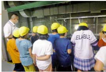
▲ポンプ室の見学
