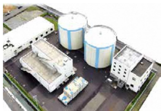
▼中新田配水場
