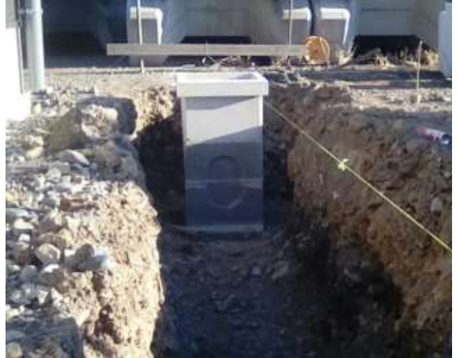
浸透ます設置
