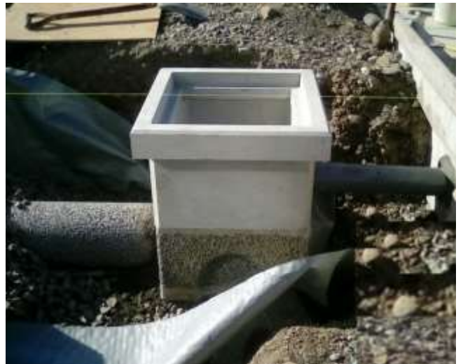
部材接続状況
