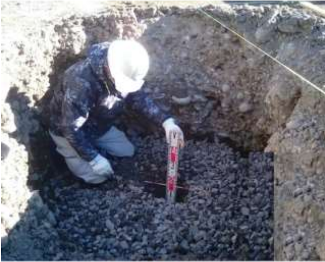
掘削・敷き均し
