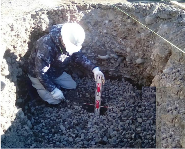
掘削・敷き均し
