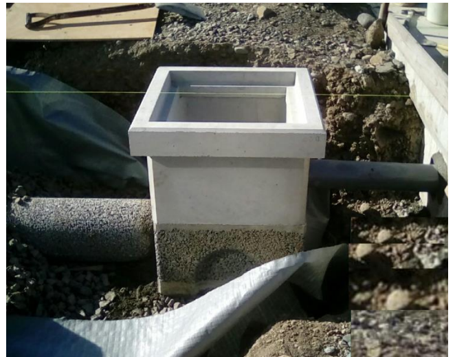
部材接続状況
