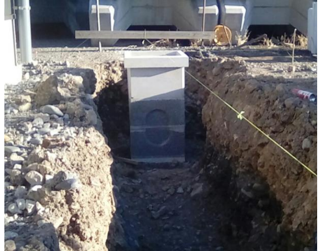
浸透ます設置
