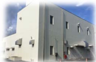
(配水ポンプ棟)
