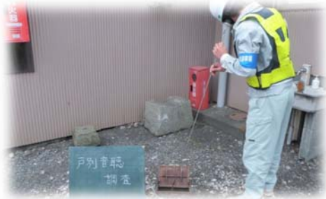
（漏水調査：戸別音聴調査）
