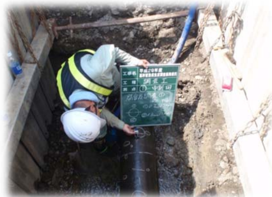
(配水本管腐食度調査)
