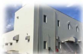
(配水ポンプ棟)
