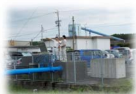
(水源井戸と導水管)
