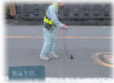
（漏水調査：路面音聴調査）
