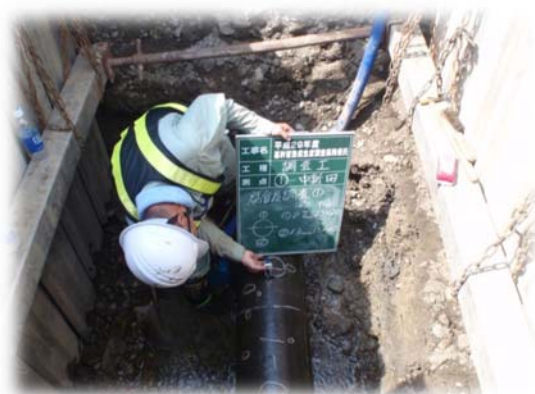
(配水本管腐食度調査)
