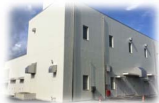
(配水ポンプ棟)
