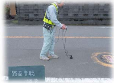
(漏水調査：路面音聴調査)
