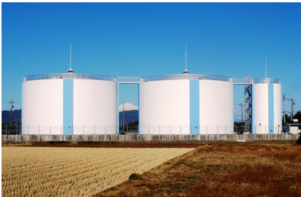
【上泉配水場配水池】
