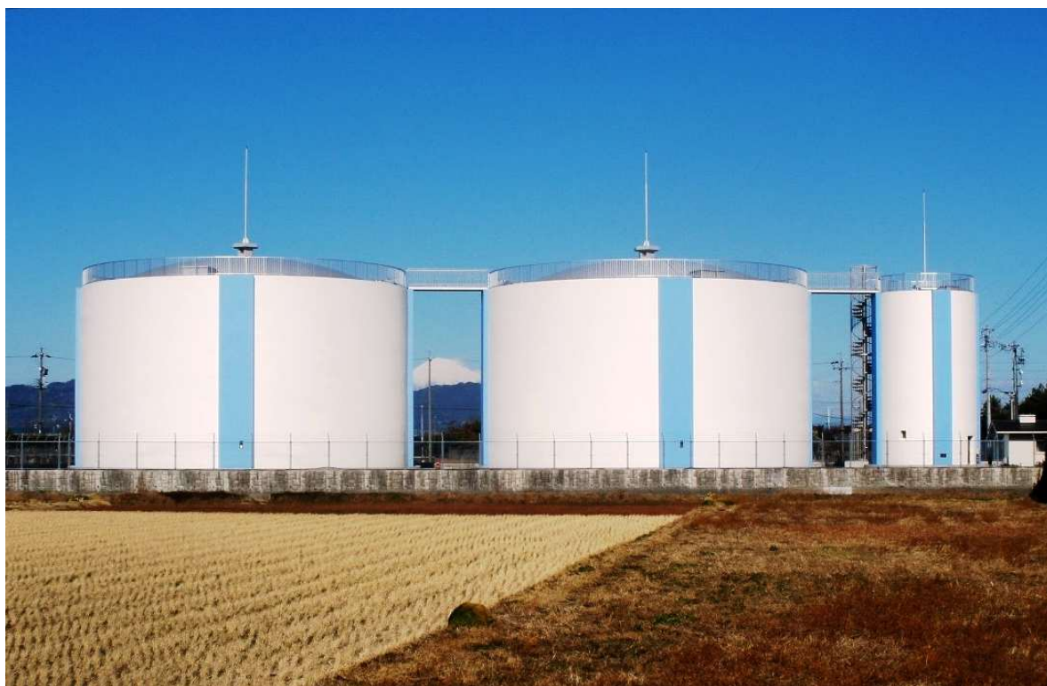
【上泉配水場配水池】
