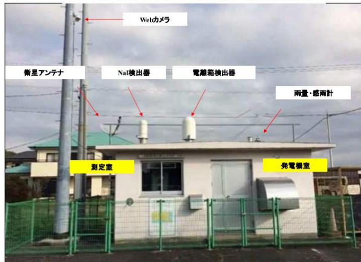
モニタリングステーション (大東支所)
