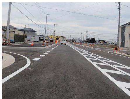
きれいに整備された道路区画線
